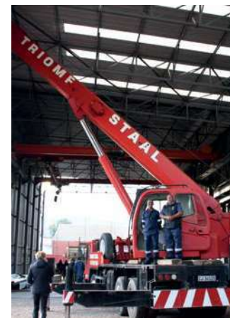
Voltooië staalstrukture word opgelaa om geïnstalleer te word
